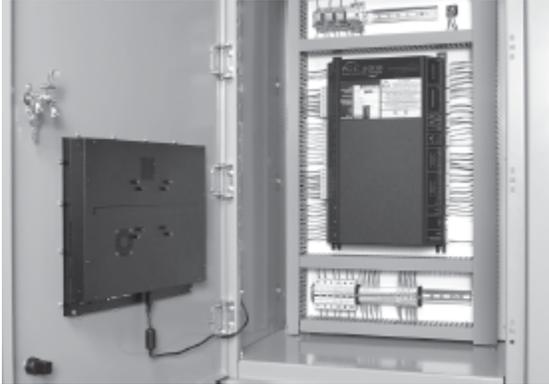
Estructura independiente NEMA 1 construida con materiales pesados de acero, pintado gris ASA 61 con sub-paneles interiores blancos.
